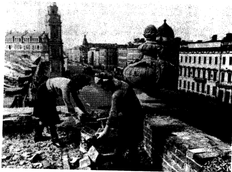
Восстановительные работы в Ленинграде на Невском проспекте, 1945 год
