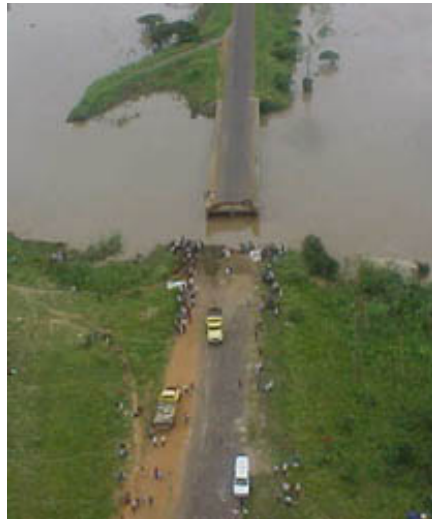
Inondations au Mozambique: la Route No.1 détruite par les pluies torrentielles.
